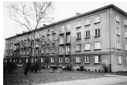
Widok jednego z budynków przy ul. Małachowskiego 6, fotografia z 1994 r. przed termoizolacją. Fototeka MKZ w Poznaniu
