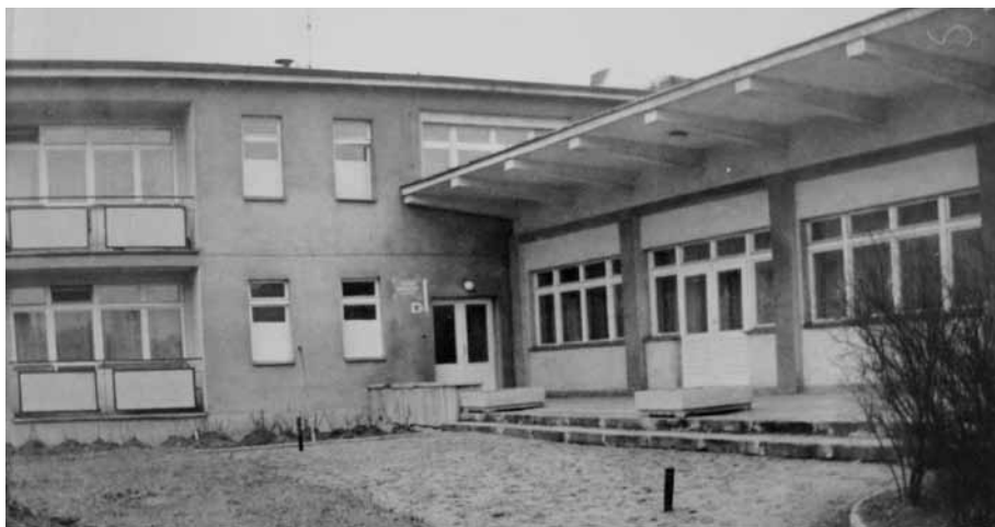
Dom Opieki Społecznej (dawny Państwowy Dom Rencistów) – widok budynku przed przebudową. Archiwum DOS
