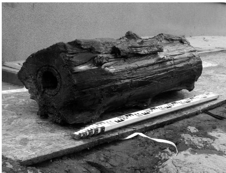
Ryc. 4. Krótszy odcinek rury wodociągowej
