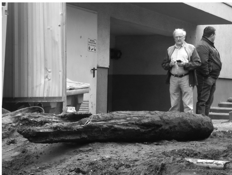
Ryc. 2. Rura bezpośrednio po wydobyciu z ziemi, obok panowie Gerard Cofta oraz Krzysztof Pacholski – wykonawca robót instalacyjnych
