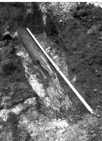
Ryc. 1. Fragment drewnianej rury wodociągowej w miejscu odkrycia w 2019 roku
