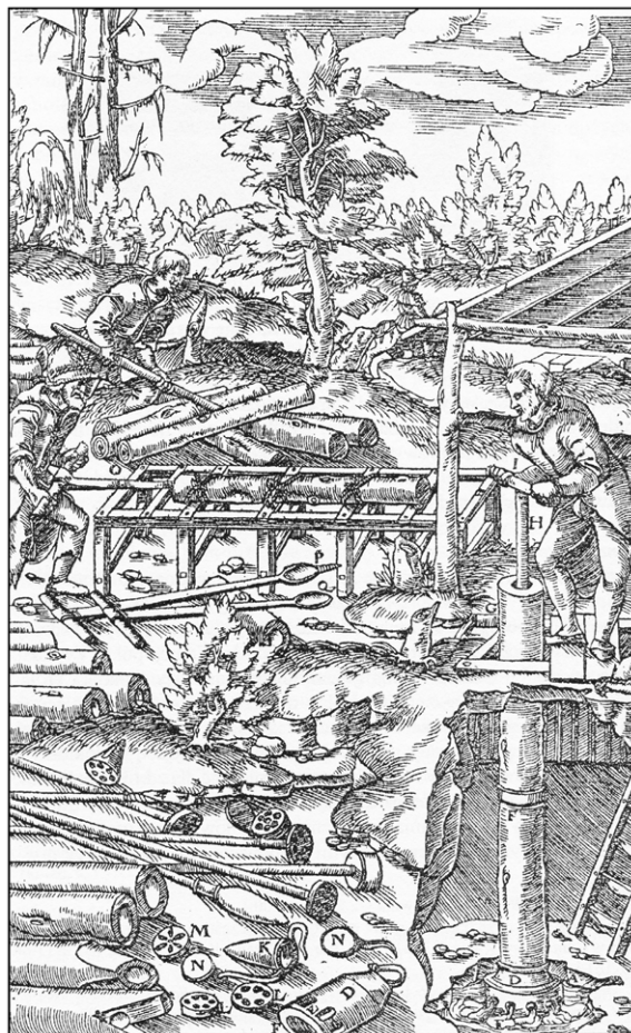
Ryc. 5. Ręczne wiercenie rur drewnianych w połowie XVI w.
