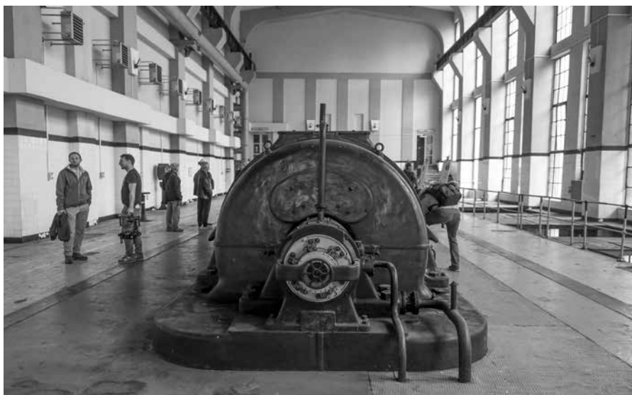
Wnętrze Elektrowni Garbary (hala maszyn) w 2017 roku, fot. Łukasz Gdak/PCD
