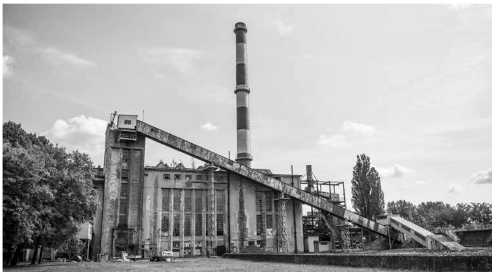
Elektrownia Garbary w 2018 roku, fot. Łukasz Gdak/PCD
